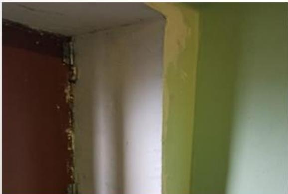
Восстановление штукатурного слоя стен и дверных откосов (тамбура и переходные лоджии)
