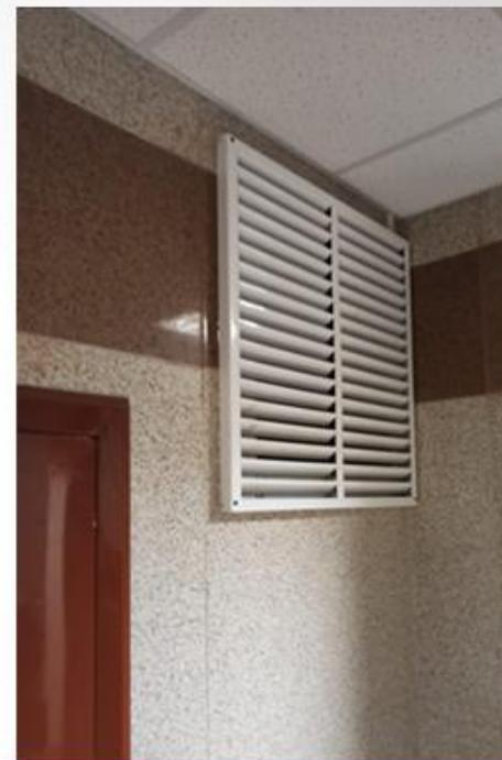
Изготовление и установка решеток ДУ в квартирных коридорах
