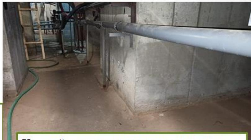
**Устройство дополнительных опор системы водоотведения**
